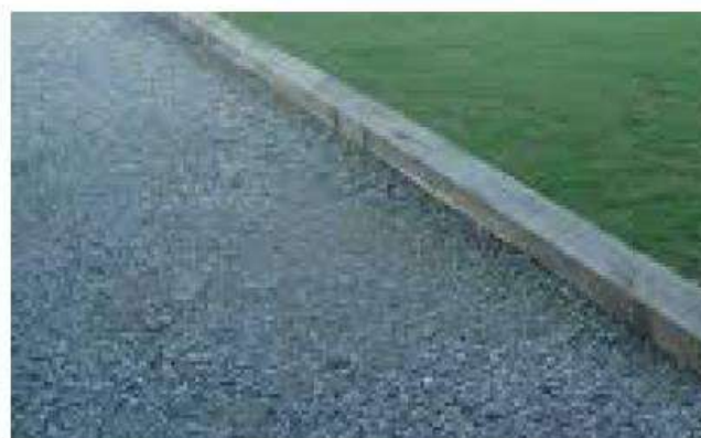
Traverses paysagères en chêne en limite de surfaces minérales (source : site internet https://www.deco-paysagere.fr/reansations/r%C3%A9alisation-avec-traverses.html )
