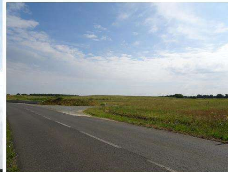
VUE DEPUIS LA D87 AU NIVEAU DE L'AIRES D'ACCUEIL : VUE PC6-01 (ÉQUIVALENT VUE 18 DE L'ANALYSE PAYSAGÈRE) _ ETAT EXISTANT
