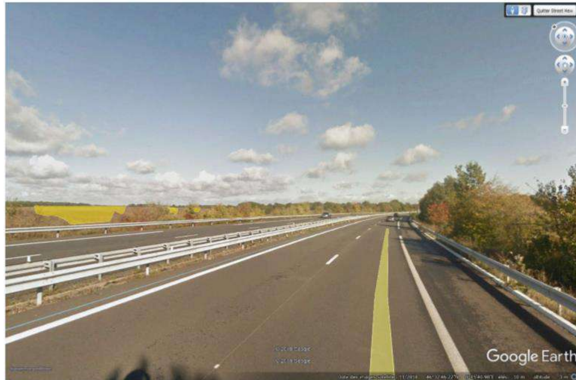
Vue 9 : Vision partielle de la zone de projet la plus vaste au Nord
