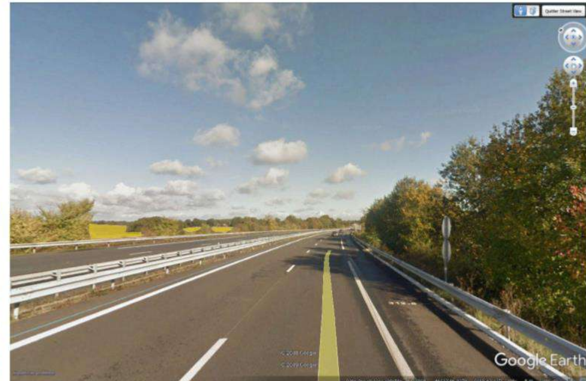
Vue 10 : La vision partielle se maintient en direction de la zone nord
